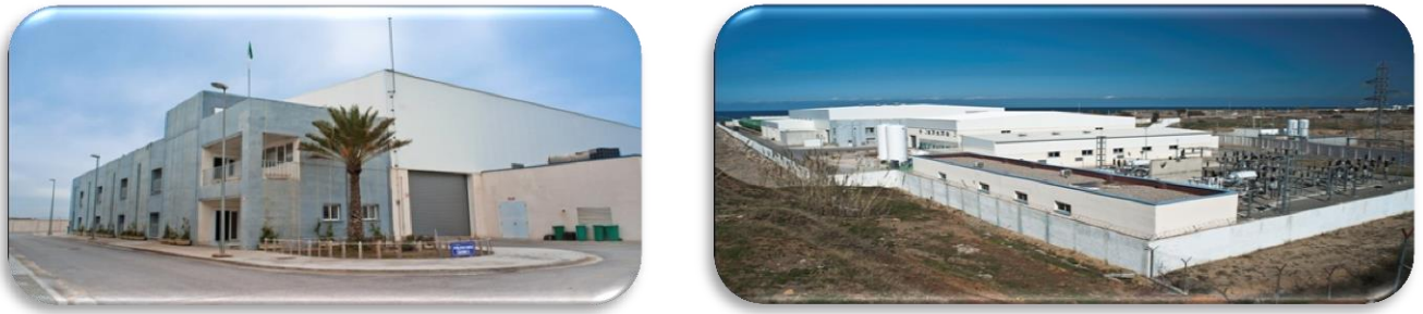
Figure (3.1.3) : Vue générale du site
