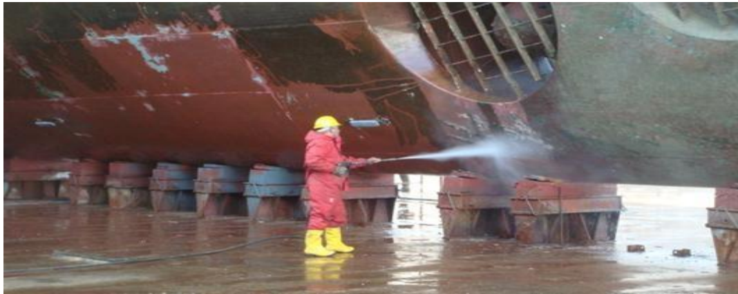
Figure III.11. Rinçage avec un jet d'eau douce en haute pression.
