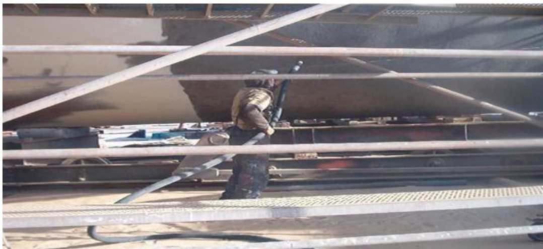
Figure III.12. Sablage de la coque.
