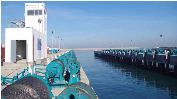
Fig. I.2.19 : élévateur à bateaux « SYNCROLIFT »
