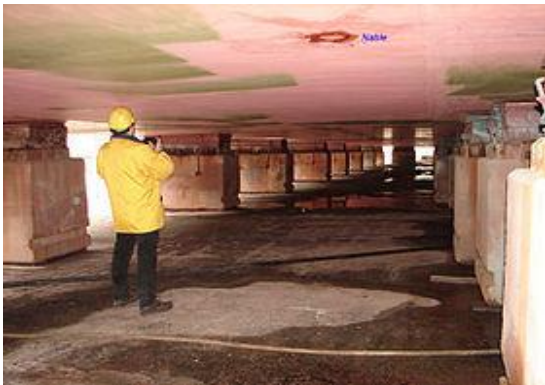
Figure I.2.2 : Vue de la ligne de tins supportant le Chassiron en cale sèche à Brest . Les tins visibles sont en béton. L'existence de plusieurs lignes de tins parallèles sous un bateau à fond plat permet de garantir sa stabilité sans la mise en place de clefs.
