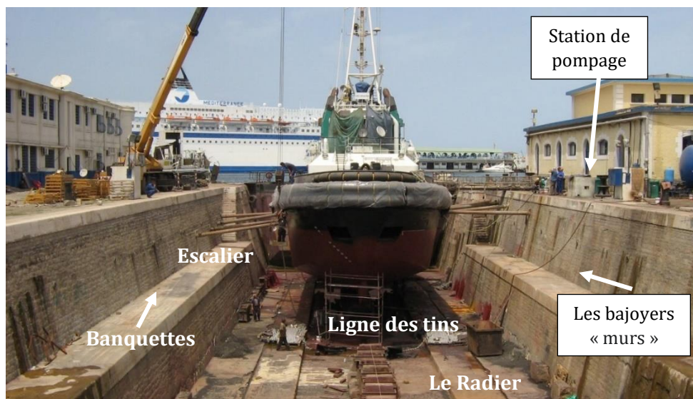
Fig. I.2.6 : Remorqueur SIDI BRAHIM de l'Entreprise Portuaire d'Annaba au niveau de la cale Sèche (forme de Radoub - petite forme) de l'ERENAV (Unité d'Alger)
